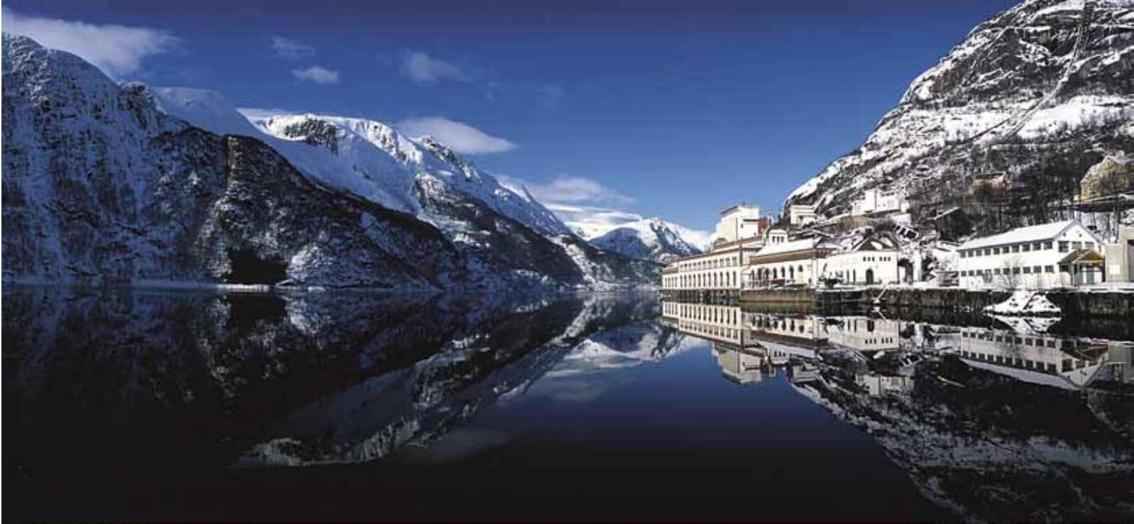
[2.7] Tyssedal kraftstasjon. Odda, Hordaland.
